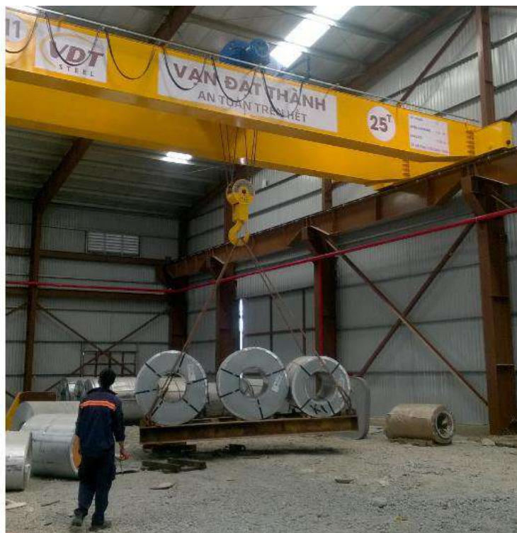
Overhead brigde load test
